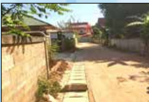
โครงการก่อสร้างรางระบายน้ำ(ค.ส.ล.) รูปตัววี พร้อม ฝาบดและงานวางท่อ(ค.ส.ล.) พร้อมบ่อพัก หมู่ที่ 3
