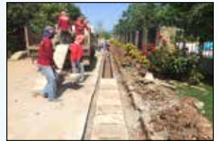
โครงการก่อสร้างรางระบายน้ำ (ค.ส.ล.) รูปตัววี พร้อมฝาบด หมู่ที่ 8 บ้านแม่ตำบุงไยง
